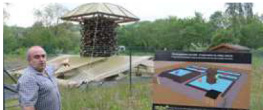
Le futur bassin de rétention sera associé au prototype de tour d'évaporation aménagée à proximité de la station d'épuration. Ils favoriseront la collecte du sel des eaux thermales usagées. OAR
